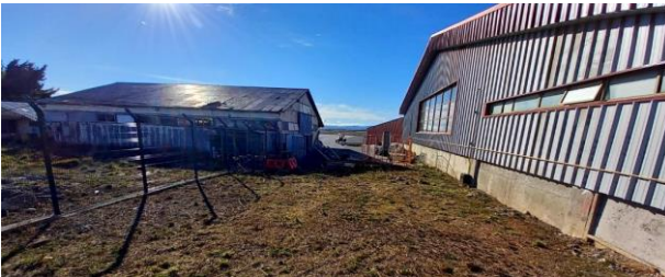
Limpieza sector carga
