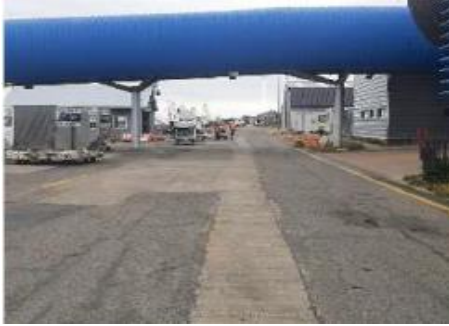
Reparación camino aeronáutico
