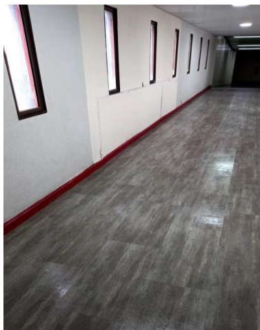
Limpieza de pisos de puentes
