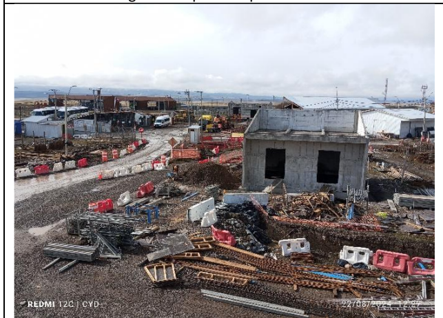
Vista Central Térmica
