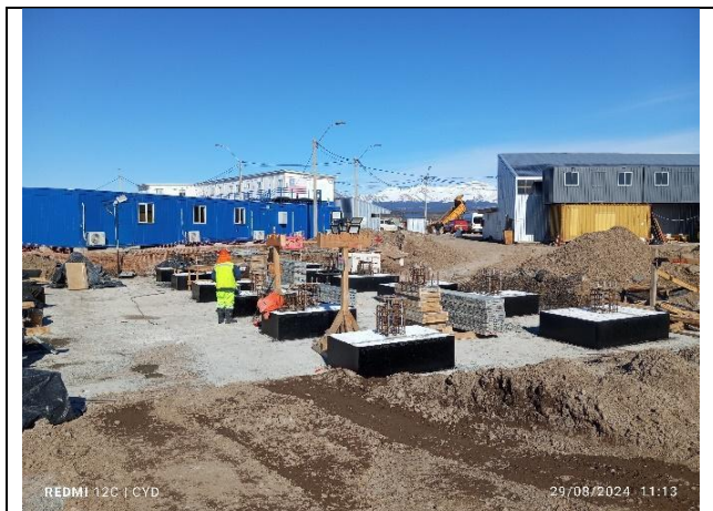
Hormigón de zapatas impermeabilizadas.
