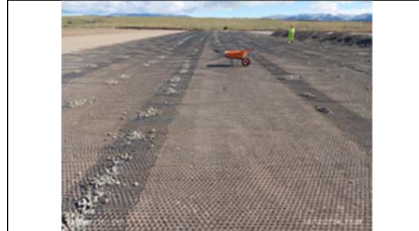
Colocación geomalla Subrasante PMA
