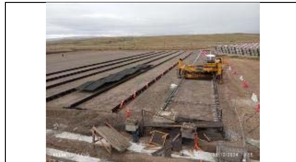
Preparación de sub- base y de moldajes pavimento / tren pavimentador Faja 1
