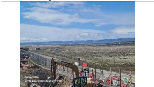
Comienzo de instalación de cierros en plataforma
