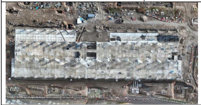
Vista aérea Edificio terminal de pasajeros
