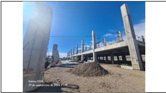
Vista general de radieres entre A - B
