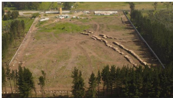
Recinto del Hospital de Coronel. Diciembre 2022. Madera acopiada rematada lista para retiro del recinto. Trabajos preliminares y bosque perimetral
