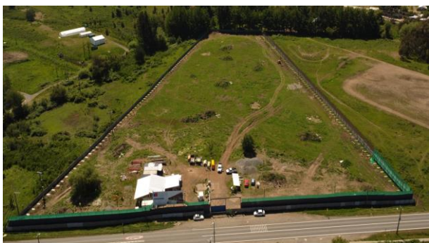
Recinto del Hospital de Santa Bárbara. Diciembre 2022. Inicio de Trabajos de cerramiento perimetral y obras preliminares.
