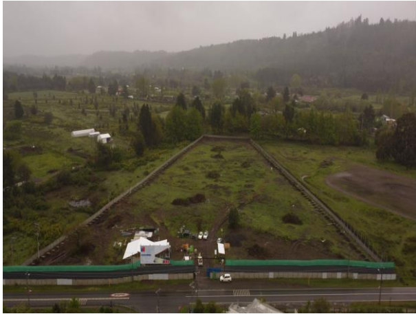
Terreno Hospital de Santa Bárbara, octubre 2022
