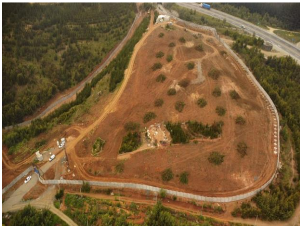
Recinto del Hospital de Lota, octubre 2022
