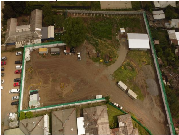
Cerramiento perimetral. Hospital de Nacimiento oct 2022
