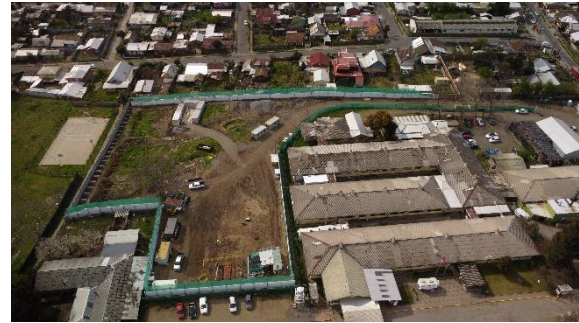
Cerramiento Perimetral. Hospital de Nacimiento
