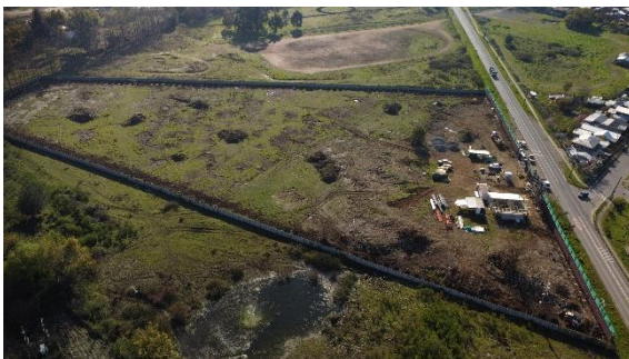
Terreno del Hospital de Santa Bárbara. Cerco perimetral
