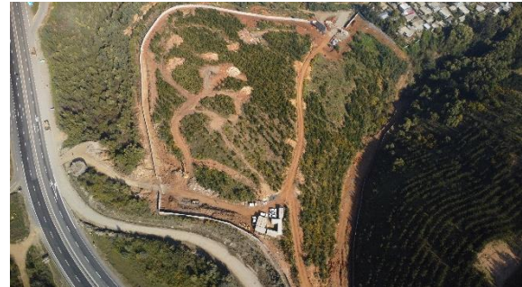
Cierro Perimetral con pandereta. Hospital de Lota
