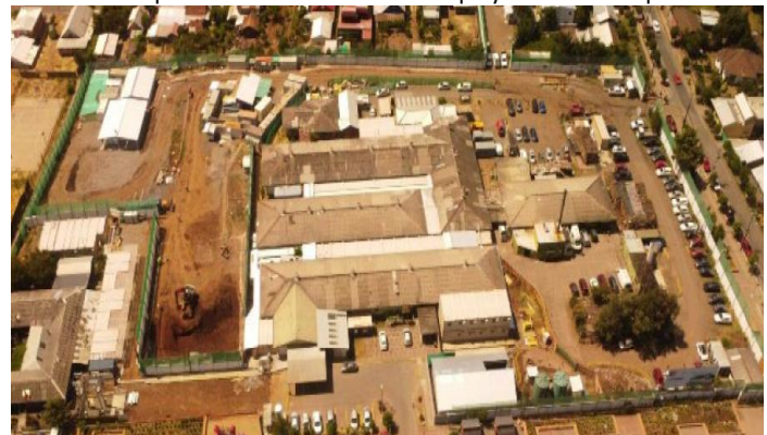
Cerramiento perimetral en el terreno del Hospital de Nacimiento
