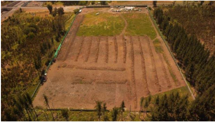
Terreno del Hospital de Coronel, con cerramiento perimetral, escarpe e instalación de faena provisoria
