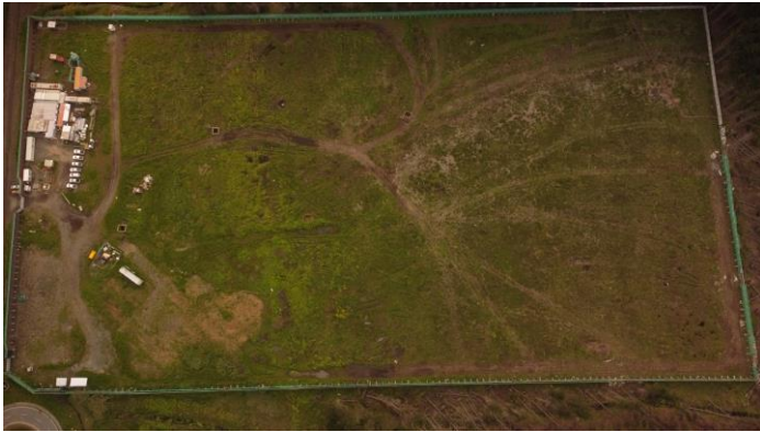
Terreno del Hospital de Coronel, con cerramiento perimetral.
