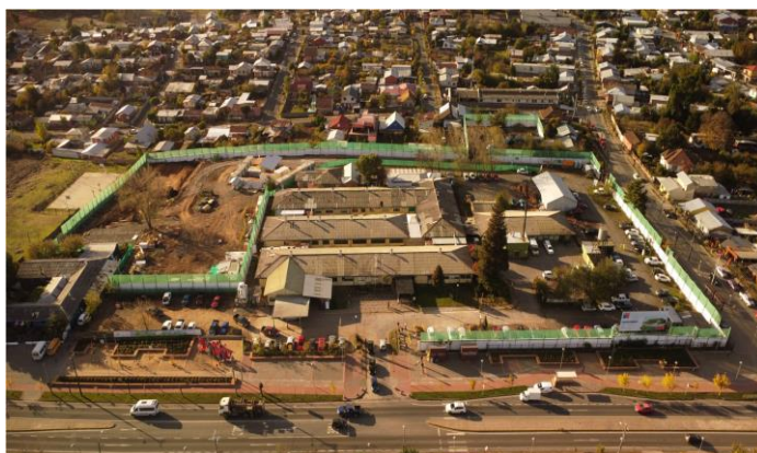
Cerramiento perimetral en el terreno del Hospital de Nacimiento
