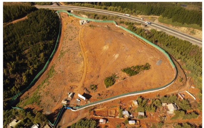
Terreno del Hospital de Lota, cerramiento perimetral.
