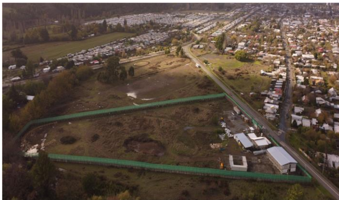
Terreno. Hospital de Santa Bárbara. Cerramiento perimetral
