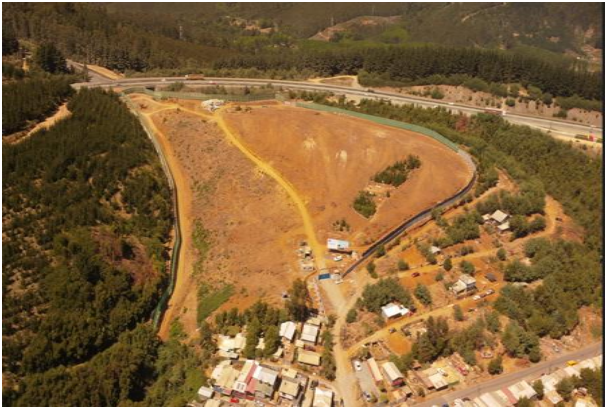
Terreno del Hospital de Lota, cerramiento perimetral.
