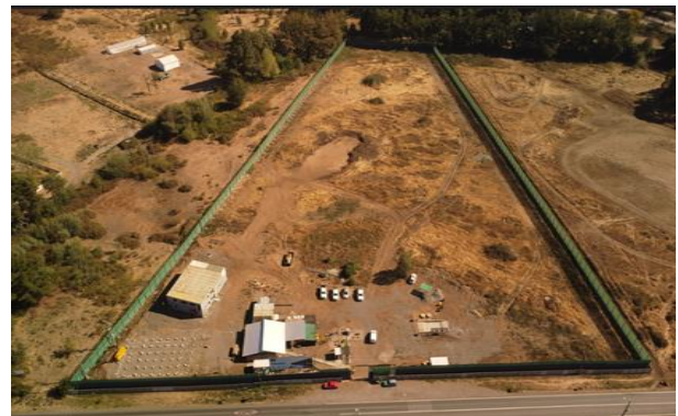
Terreno. Hospital de Santa Bárbara. Cerramiento perimetral
