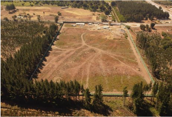
Terreno del Hospital de Coronel, con cerramiento perimetral
