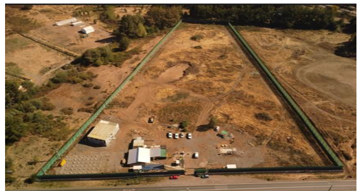
Terreno. Hospital de Santa Bárbara. Cerramiento perimetral
