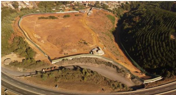
Terreno del Hospital de Lota, cerramiento perimetral.
