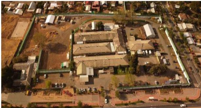
Cerramiento perimetral en el terreno del Hospital de Nacimiento
