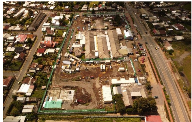
Sector Excavación Fundación Hospital de Día y Sala Cuna
