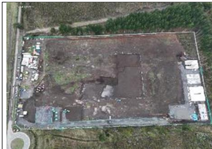
Vista aérea acceso, oficinas OHLA-IF, escarpe general. Hospital de Coronel
