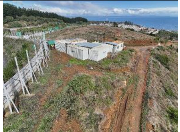
Vista aérea hacia acceso Oeste. Hospital de Lota.
