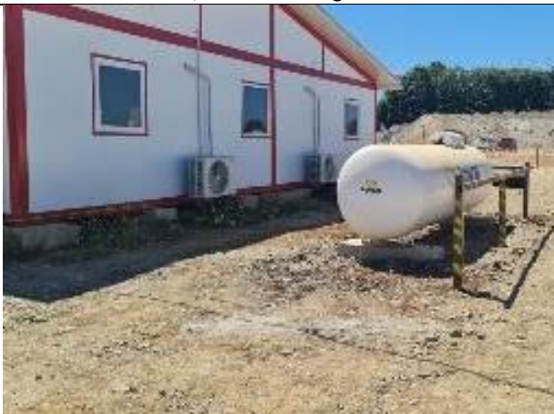
Instalación de Faenas, Instalación de gas
