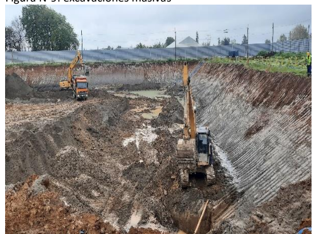
Figura N°9: excavaciones masivas
