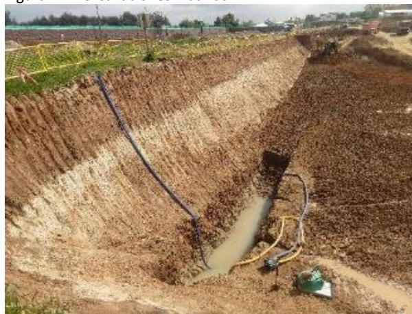
Figura N°4: excavaciones masivas
