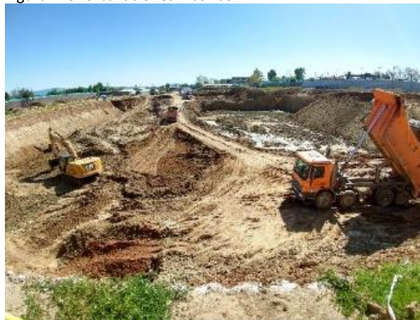
Figura N°3: excavaciones masivas
