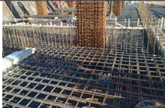
Hormigonado Losa Fundaciones
