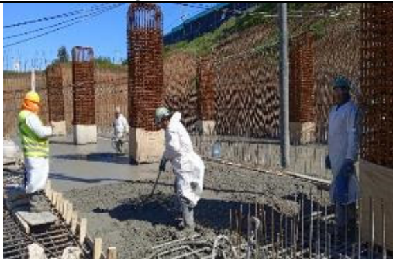
Hormigonado Losa Fundaciones
