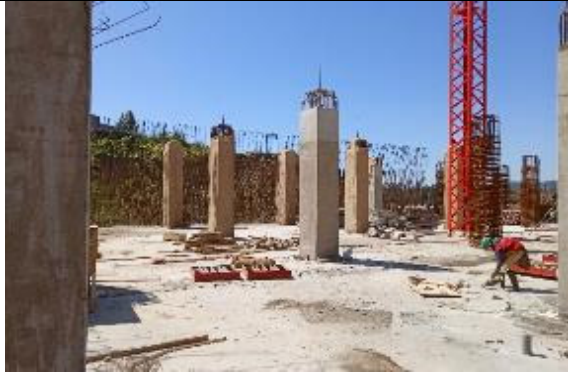
Enfierraduras Losa Fundaciones
