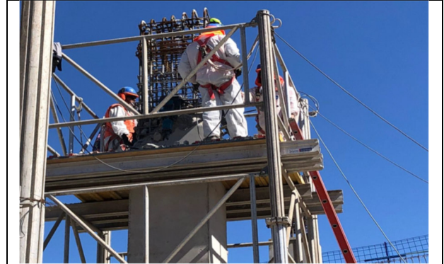
Uso correcto de Elementos de Protección Personal
