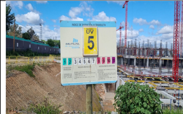
Segregaciones en obra
