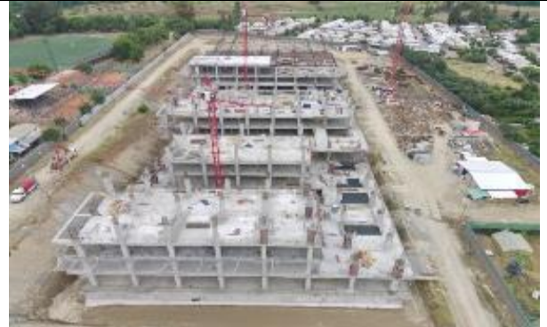
Colocación de placas en tabiques interiores 2° Subterráneo
