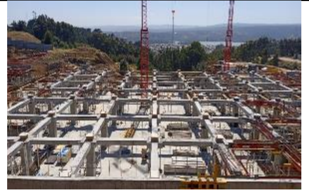
colocación de aisladores acústicos
