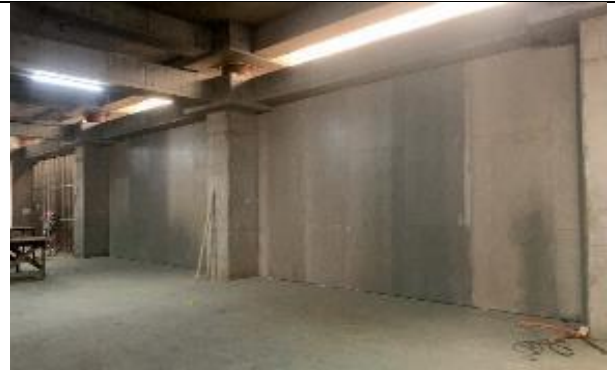
Instalación de ductos de clima en 1° subterráneo
