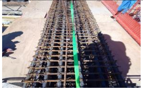
colocación de aisladores acústicos
