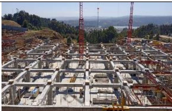
Enfierradura de Vigas Losas y Hormigón
