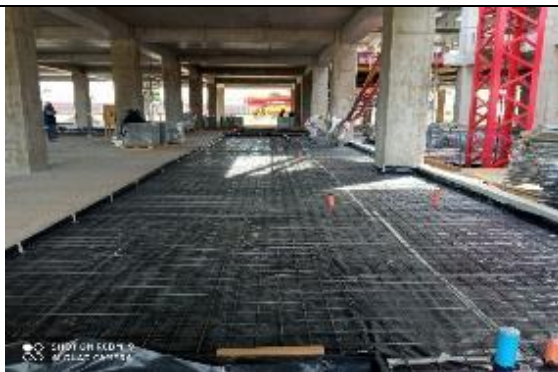
Pavimentos Sobre Losa
