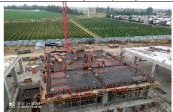
Enfierradura de Vigas Losas y Hormigón
