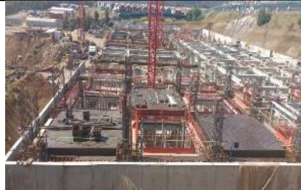
Instalación de pilares
