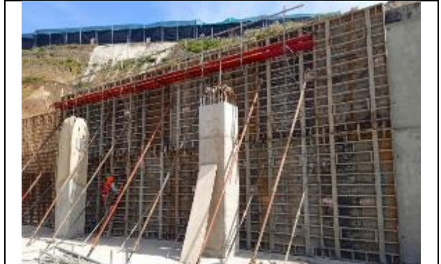
Se ejecuta faena "Pausa Hormigonado" de muro de Contención
