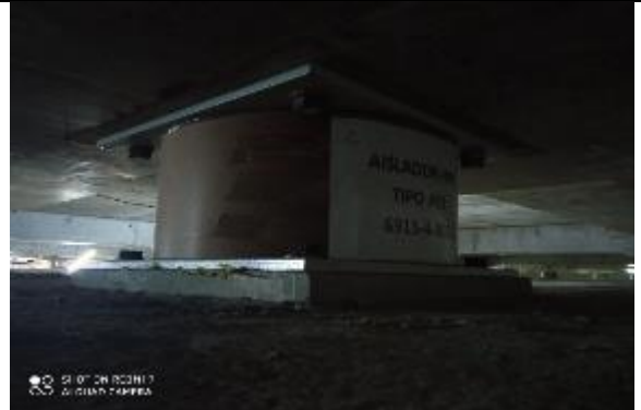
Instalación de Aisladores Definitivos
