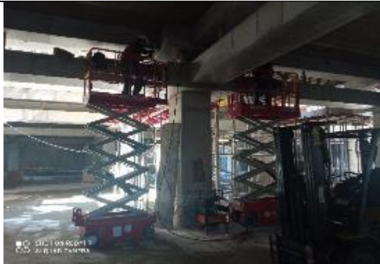
Instalación de Aisladores Definitivos
