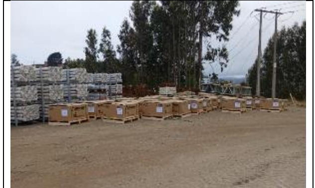
Muestra llegada y acopio en obra, de los aisladores sísmicos
