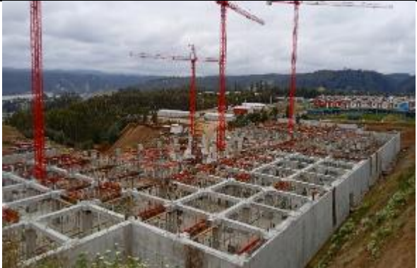
Muestra vigas y capiteles en hormigón sector Noreste nivel S3 antes de la instalación de Aisladores Sísmicos
