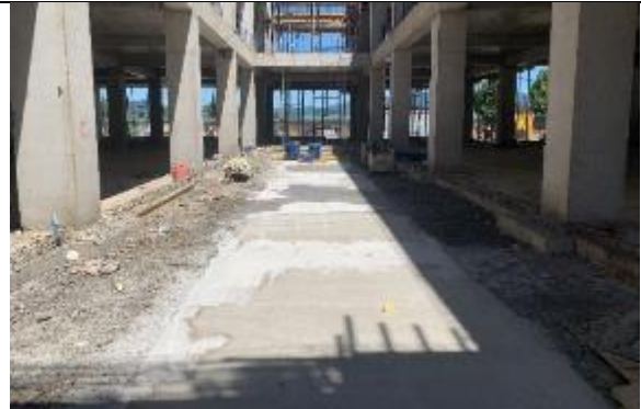
moldaje, enfierradura y hormigonado de losa cielo 2° Piso
