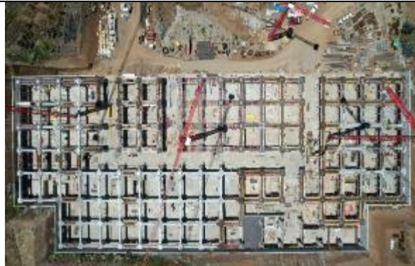
Se ejecuta faena "Pausa Hormigonado" de muro de Contención
