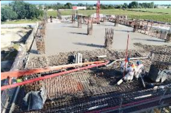
Enfierradura de viga y capitel
