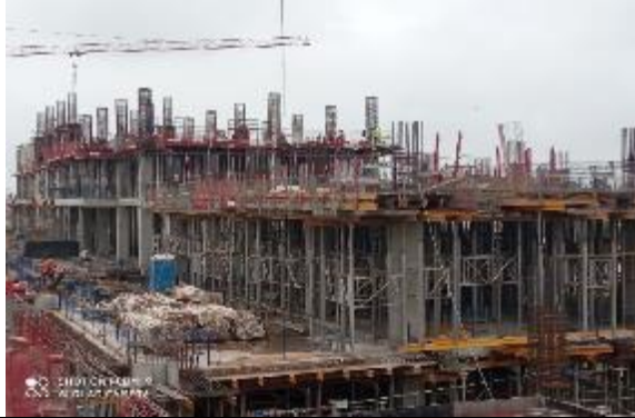
Vista aérea de las obras en HPR
