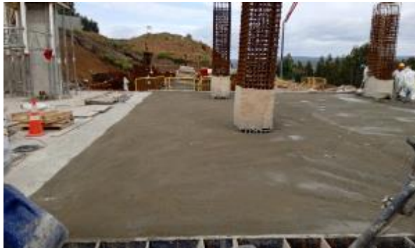
instalación de moldaje para Vigas y Capiteles
