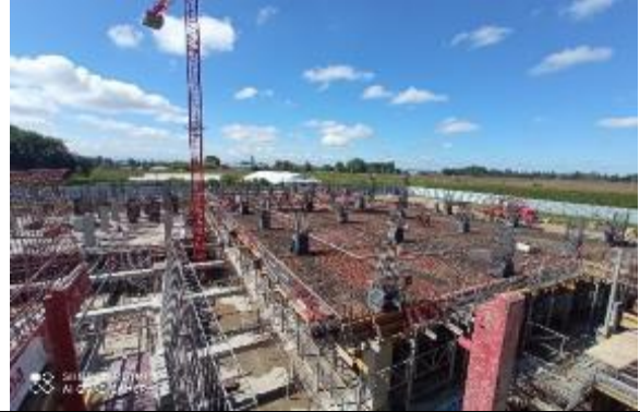
Enfierradura de pilares y losa
