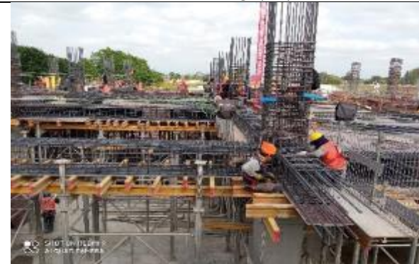
Enfierradura de pilares y losa
