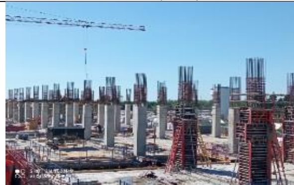
Enfierradura de pilares y losa
