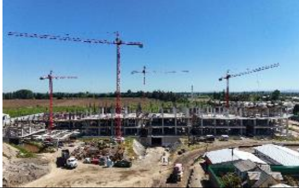
Enfierradura de viga y capitel
