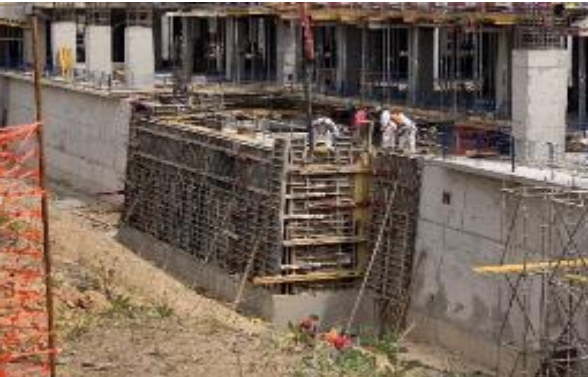
muro de contención de foso de ascensor
