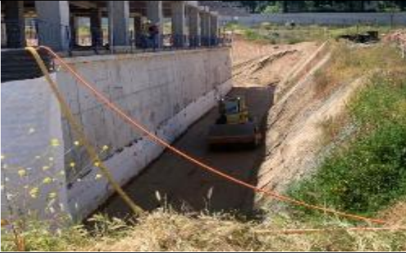
moldaje, enfierradura y hormigonado de losa cielo 1° Piso
