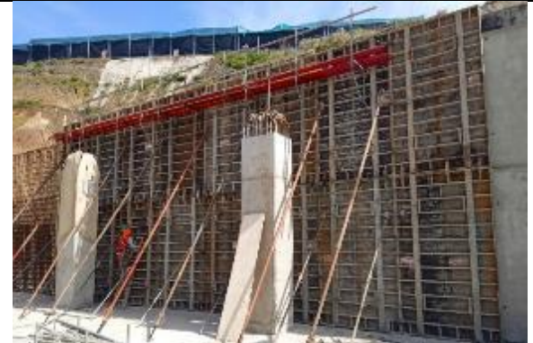
moldaje para Muro Contención
