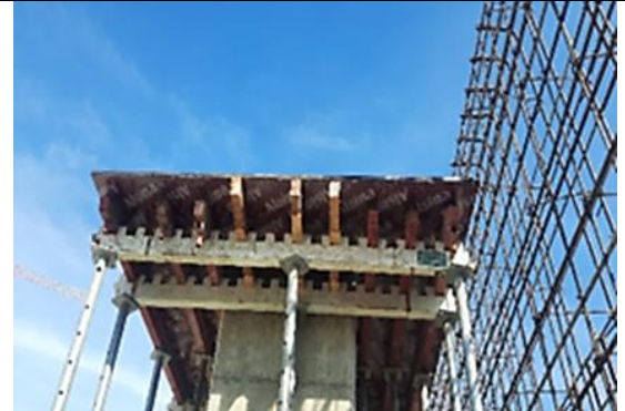
Trabajos montaje de fonde de vigas y capitel
