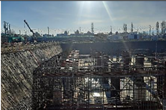
Trabajos montaje de fonde de vigas y capitel
