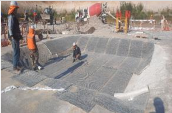
Trabajos enfierradura de fundación
