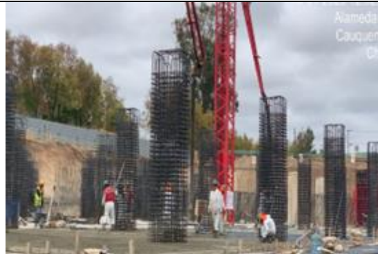
Aplicación de Rugasol 200 Sika en hormigonado de pilares
