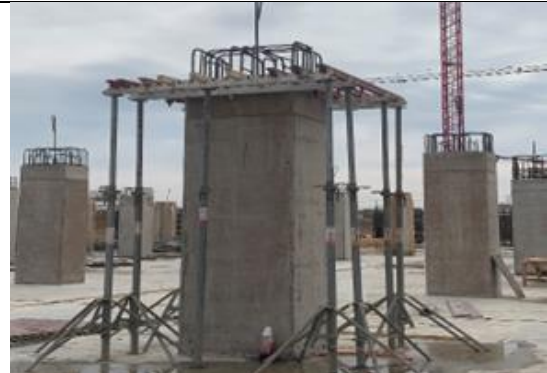
Moldajes en pilares para capiteles
