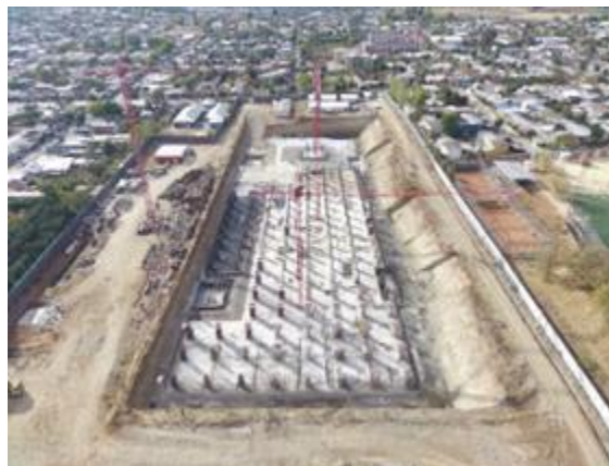
Vista aérea de las obras en HCQ
