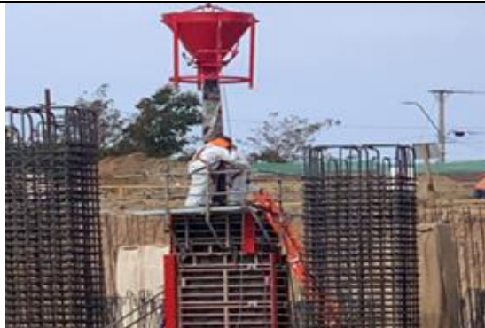
Hormigonado en losa de fundación
