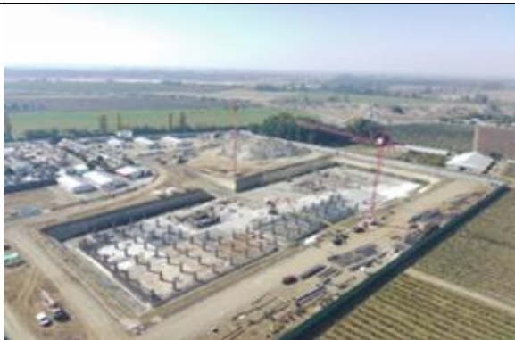
Colocación manta bentonita bajo fundaciones
