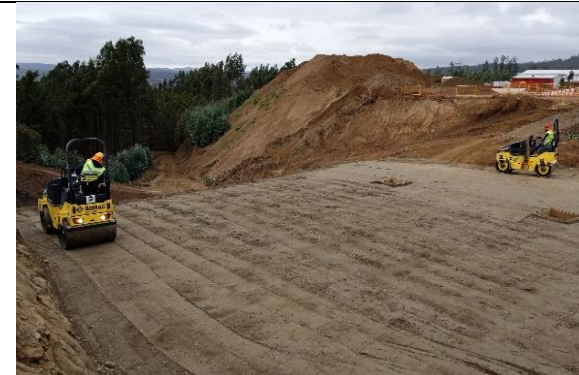
Rellenos estructurales del sector quebrada
