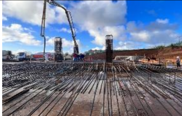
Hormigón de protección del sello de excavaciones
