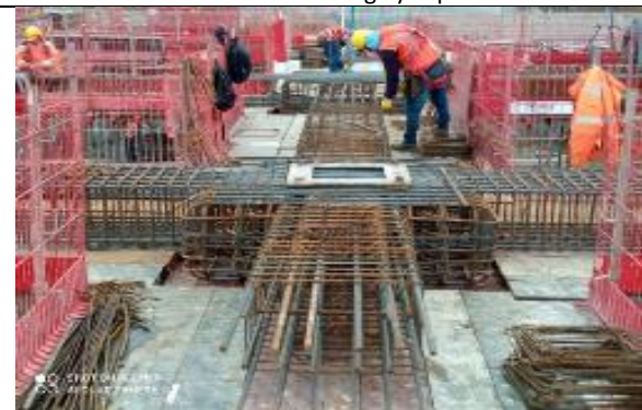
Enfierradura de pilares y losa
