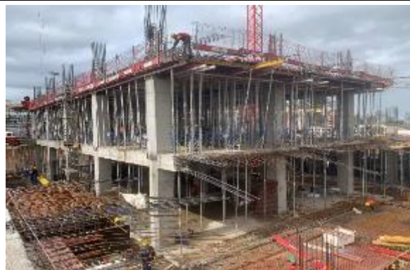
Ejecución de obra gruesa cielo 2° Subterráneo
