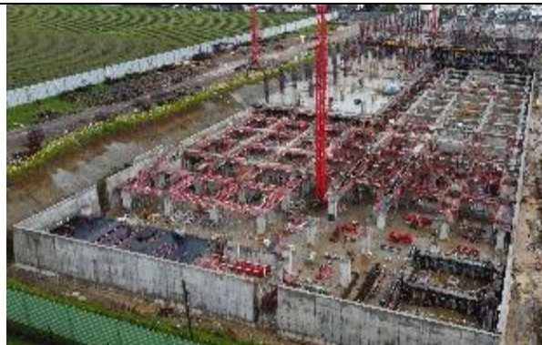
Enfierradura de viga y capitel
