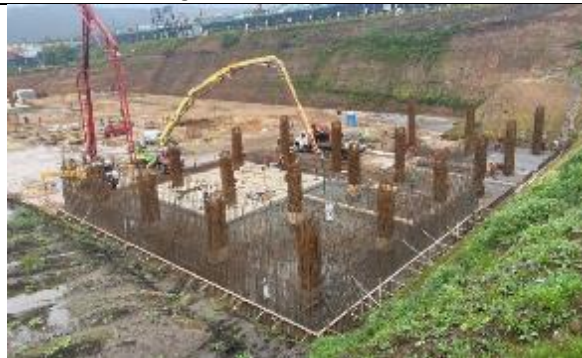
Hormigonado de losa de fundaciones
