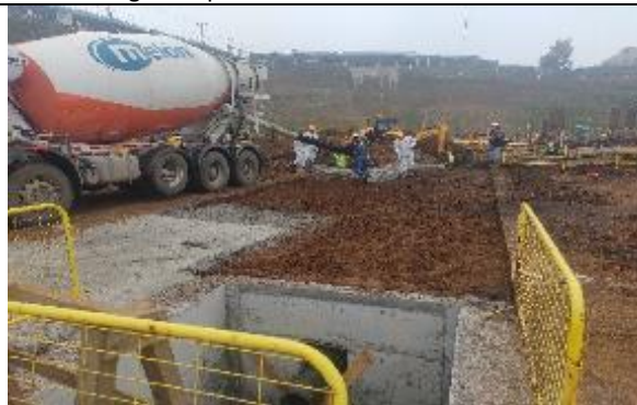
Hormigonado de losa de fundaciones
