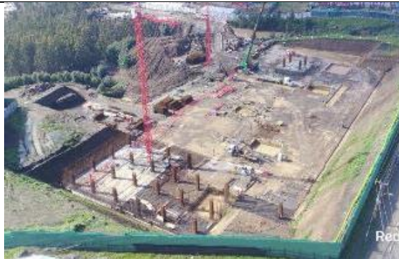
Vista aérea de las obras en HCN
