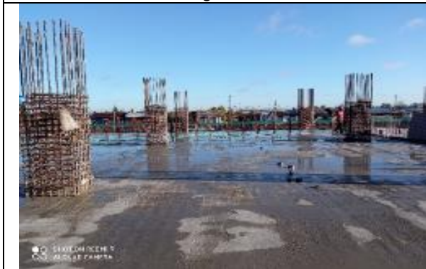
Hormigón de losas
