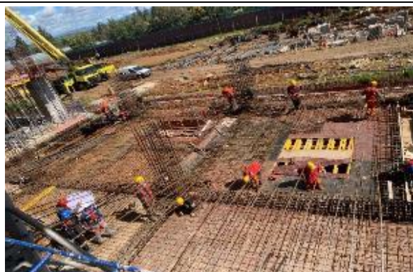
Ejecución de obra gruesa cielo 2° Subterráneo
