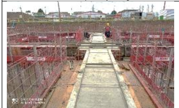
enfierradura y moldaje de viga
