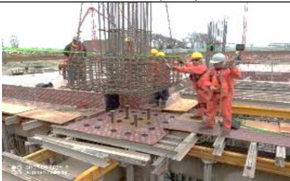
Enfierradura de capiteles y losa
