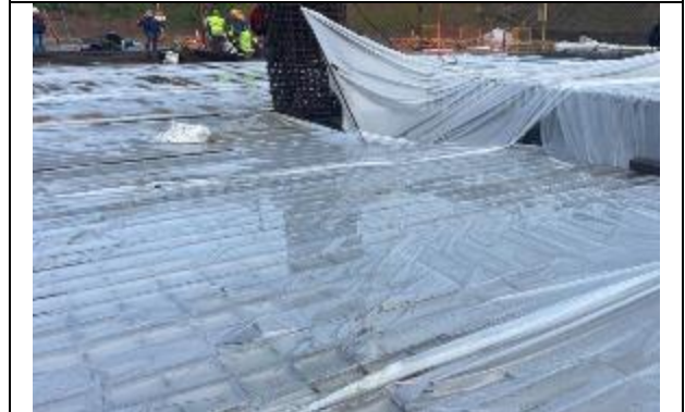
Protección de enfierraduras para fundaciones
