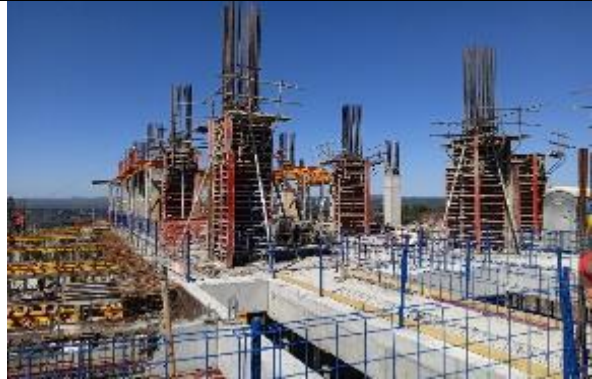
Instalación moldaje pilares superestructura
