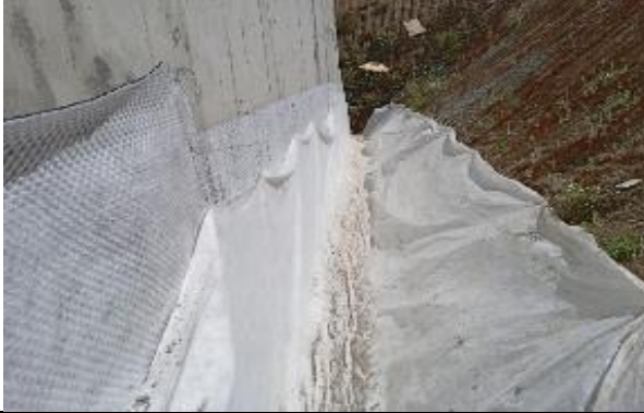
losa hormigonada superestructura
