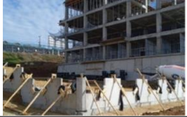
Ejecución de rellenos trasdós en el perímetro
