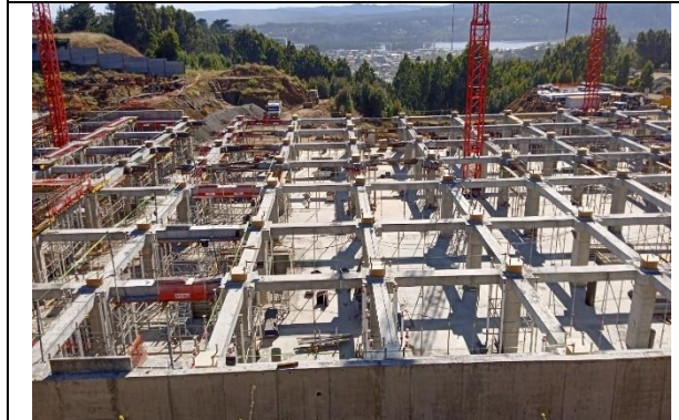
armado de enfierraduras de losa
