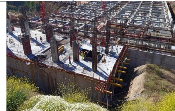
losa hormigonada superestructura
