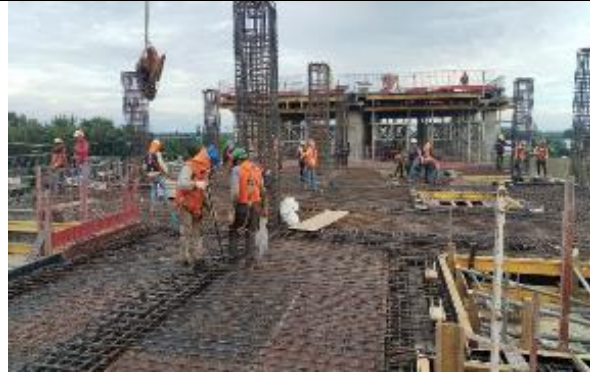
Enfierradura de Vigas Losas y Hormigón
