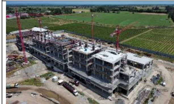
Vista aérea de las obras en HPR
