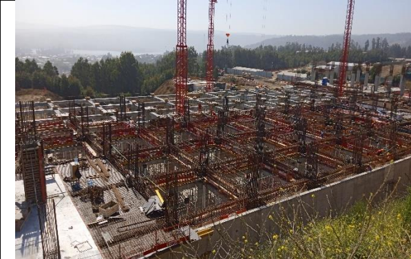
armado enfierraduras losa de la superestructura
