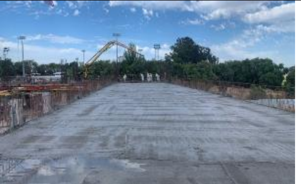
Avances en sobrelosas en 1° Subterráneo
