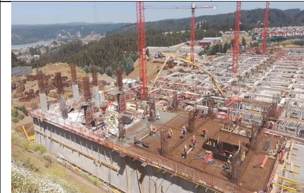
losa hormigonada superestructura
