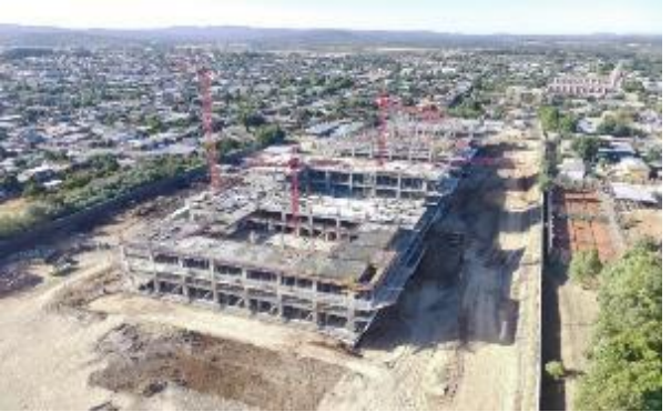
: moldaje, enfierradura y hormigonado de losa cielo 2° Piso
