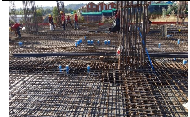
armado de enfierraduras de losa
