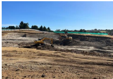
Visita a Terreno Hospital de Puerto Varas 09.02.2024
