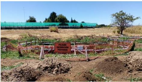
Visita a Terreno Hospital de La Unión 23.01.2024
