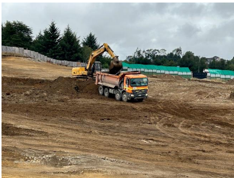
Visita a Terreno Hospital de Puerto Varas 15.01.2024
