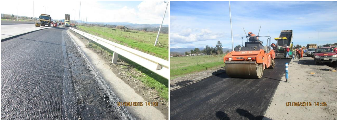
Colocación de Geogrilla, Riego de Liga y Carpeta Asfáltica en Bache; Eje N°104 Plaza de Pesaje Horcones, Lado Derecho Tramo A Sector II del km: 0,032 – 0,215.
