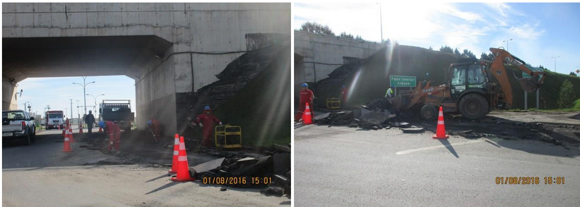
Fresado y Retiro de Escombros, Paso Inferior Celulosa Arauco Eje N°100, Lado Derecho Tramo A Sector II del km: 0,096 – 0,113.
