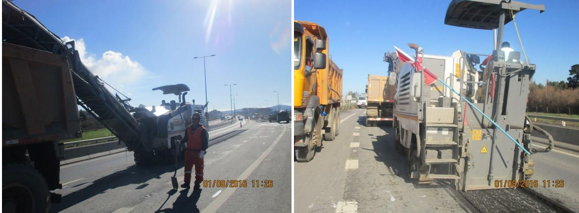
Fresado Eje N°104, Plaza de Pesaje Horcones Lado Derecho Tramo A Sector II del km: 0,032 – 0,188.
