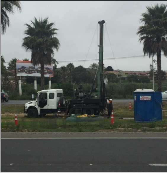
Trabajos de Sondajes por la SC
