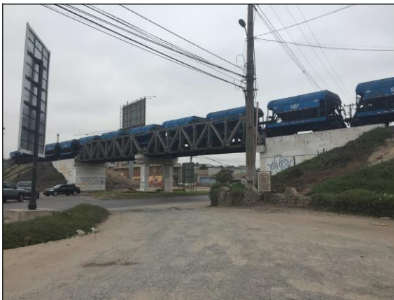
Cruce Ferroviario Ruta 5
