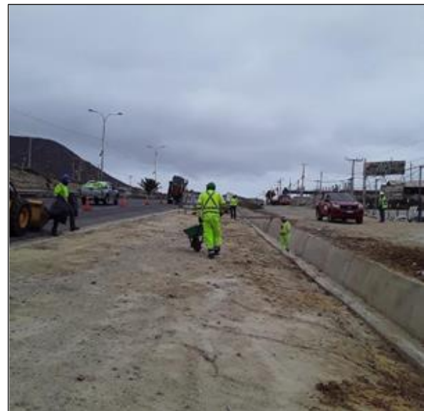
Ruta 5, Dm 457+900 Trabajos en la Faja
