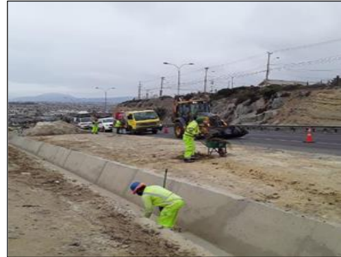
Ruta 5, km 457,800 limpieza fosos Coquimbo
