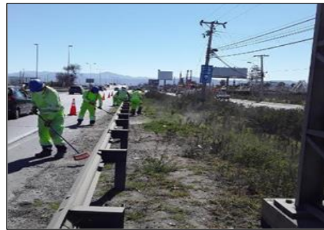
Ruta 5, Dm 469+400 Limpieza de bermas.
