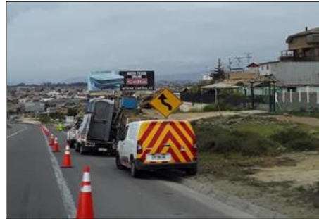
Ruta 5, Dm 458+300 Trabajos limpieza de faja.
