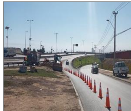
Ruta 5, Dm 461+700 Reparación cámara.
