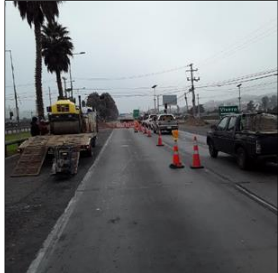
Ruta 5, Dm 465+600 Reparación calzada.
