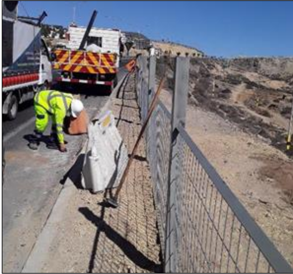
Ruta 5, Dm 428+700 Mantención y Limpieza de la faja.
