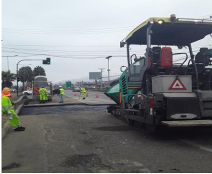
Dm 465+600 Reparación de bache.
