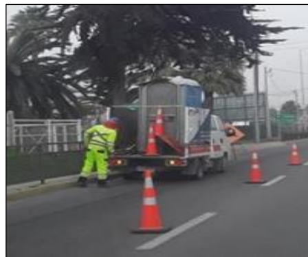
Ruta 5, Dm 467+100 Trabajos de Roce y Limpieza.
