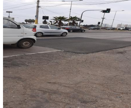
Dm 465+600 Bache reparado
