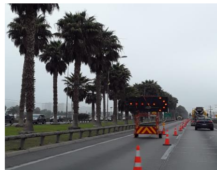
Desvío de Tránsito Dm 465+600 Reparación bache.
