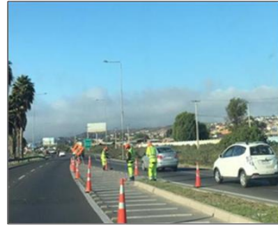
Ruta 5, Dm 463+200 Barrido y limpieza.
