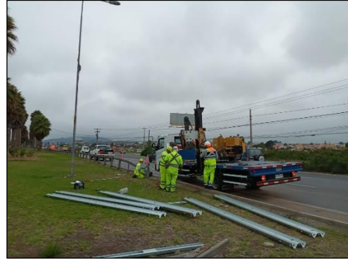
Ruta 5, Dm 464+300 Instalación Defensas camineras.
