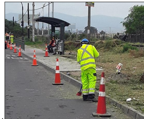
Ruta 5, Dm 471+800 Mantenimiento y Limpieza de la faja.
