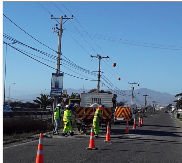
Ruta 5, Dm 470+000 Reparación de pavimento.
