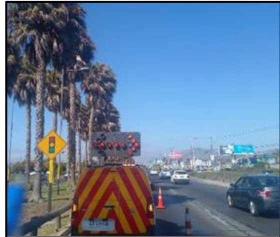
Ruta 5, Dm 465+300 Segregación de emergencia por accidente.
