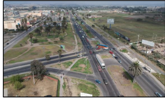
Foto 1: Ruta 5, Dm 472+400 Trincherera N°4. Vista hacia el sur, HOY.
