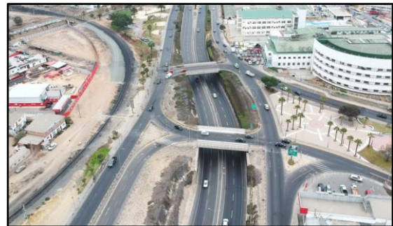
Foto 3: Ruta 5, Dm 461+700 Trincheras N°2, HOY.
