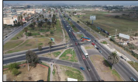
Foto 1: Ruta 5, Dm 472+400 Trincheras N°4. Vista hacia el sur, HOY.
