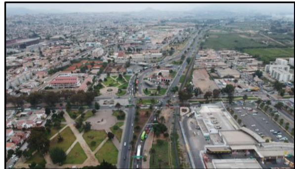
Foto 3: Ruta 5, Dm 473+000 Trincherera N°4, HOY.
