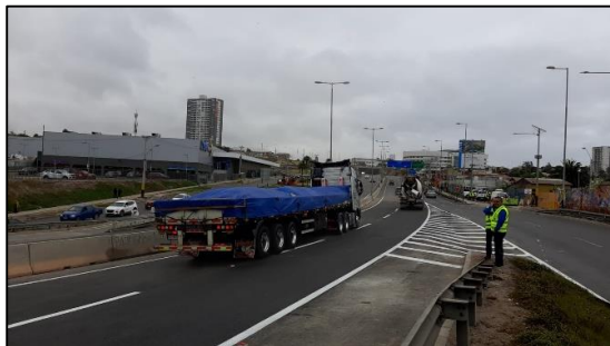
Foto 2: Ruta 5, Dm 462+000 socavón reparado Juan Antonio Ríos.
