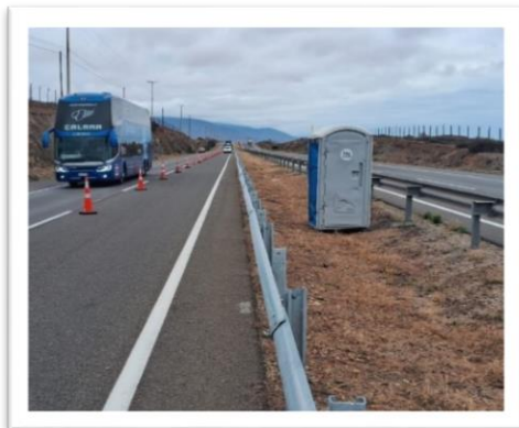
Foto 1: Ruta 5, Trabajos de instalación de barreras, tramo interurbano, proyecto seguridad vial.
