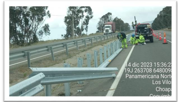
Foto 3: Ruta 5, Trabajos de cambio de barrera metálica, proyecto vial, tramo interurbano.
