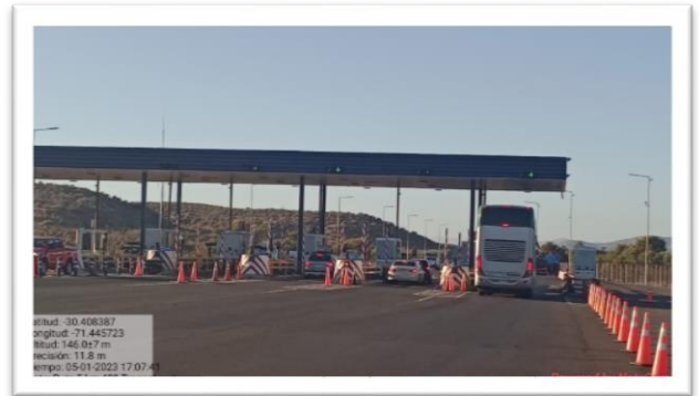
Foto 2: Ruta 5, Dm 408. Supervisión contingencia por feriado de 01 de Mayo.
