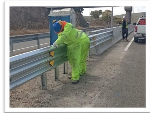
Foto 2: Km. 294, Instalación de Transición entre barreras metálicas y barreras de hormigón, sector interurbano.
