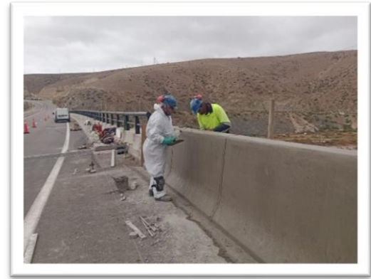
Foto 1: Ruta 5, trabajos de construcción de barrera de hormigón, acceso puente el teniente.
