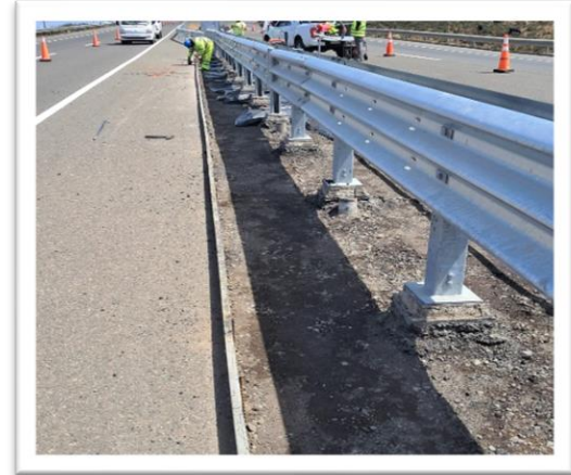
Foto 1: Ruta 5, km 311, Sector Interurbano, construcción de transfer.
