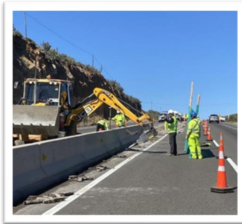
Foto 1: Ruta 5, Trabajos de retiro de barrera de hormigón, sector interurbano.
