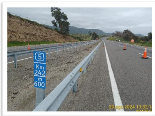
Foto 2: Ruta 5, Instalación señalización hectométrica sobre defensa metálica, interurbano.
