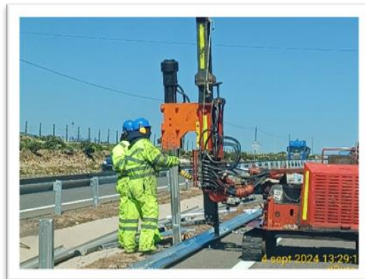
Foto 3: Trabajos de hincado de postes para instalación de barreras H1, sector interurbano.
